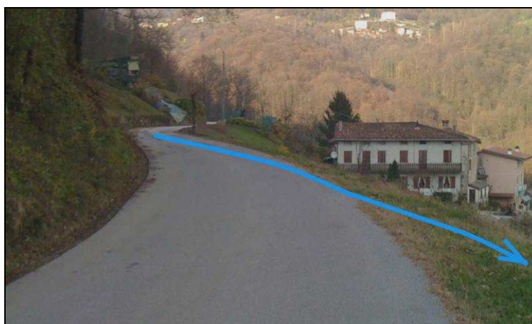
Foto 4 - Percorso di scarico dell'acqua piovana sulla strada a monte
