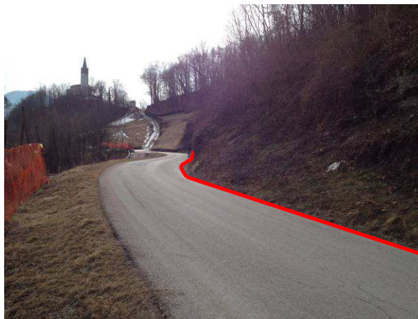
Foto 8 – Canaletta esistente da ripristinare
