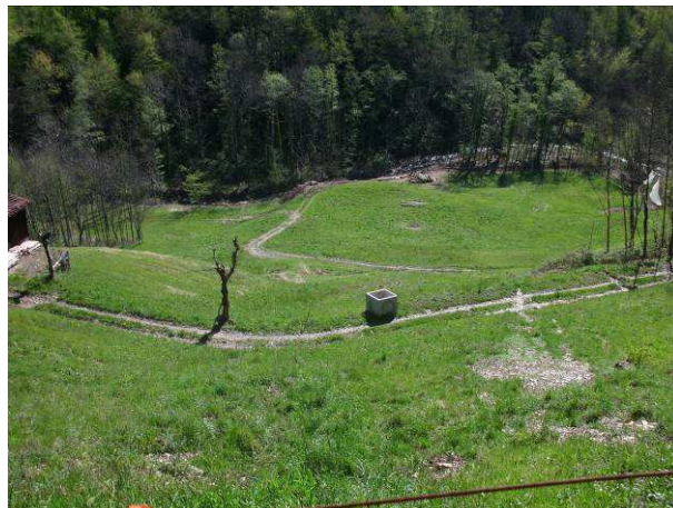
Foto 2 - Vista della ex strada franata del torrente a valle dove saranno scaricate le acque
